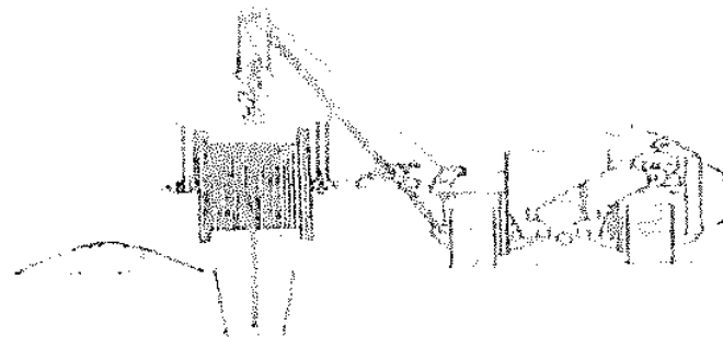
Полагане на кабел с кабелопологачел
