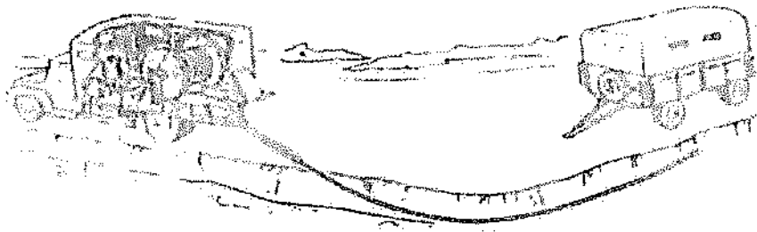
Полагане на кабел със специализирано закрито МПС
