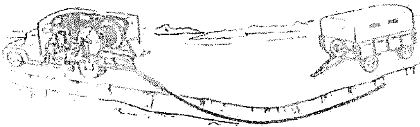
Полагане на кабел със специализирано закрито МПС
