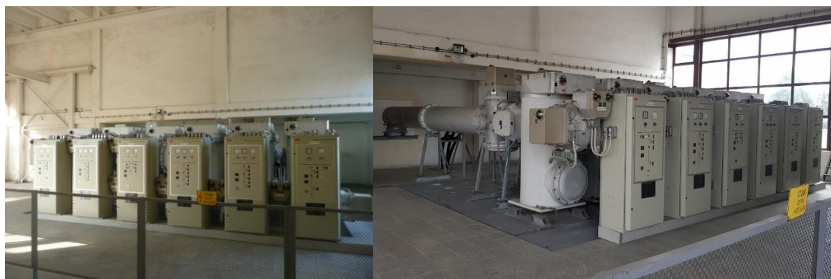
Фигура 4: 110 kV част (закрита)
