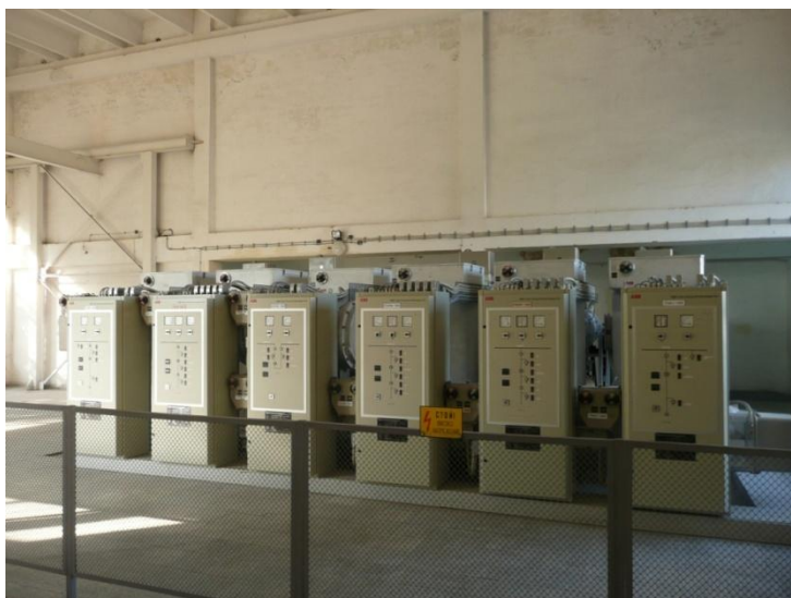
Снимка 10: Частта 110 kV от затворен тип
